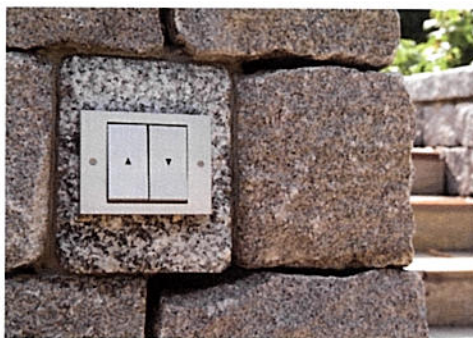
△ Die Lichtsteuerung im Garten funktioniert dämmerungsabhängig und vollautomatisch via Instabus-KNX/EIB-System. Bedient wird unter anderem über Schalter von Gira.
